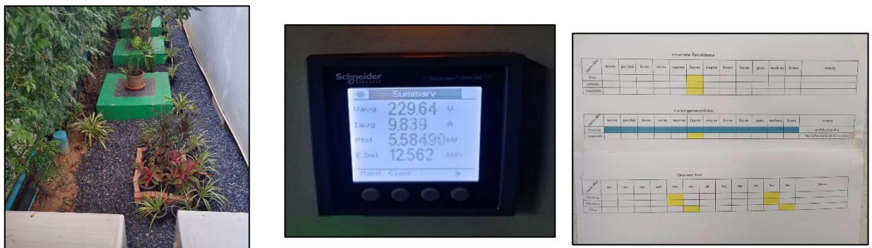
รูปที่ 3-9 ระบบบำบัดน้ำเสีย มิเตอร์ระบบบำบัดน้ำเสีย และตารางกำหนดระยะเวลาในการซ่อมบำรุงระบบบำบัดน้ำเสีย
