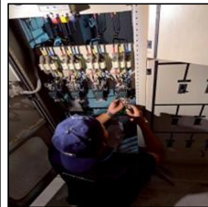
รูปที่ 3-19 การเช็คตู้คอนโทรลกระแสไฟฟ้าปั้มน้ำบาดาล
