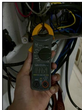
รูปที่ 3-19 การเช็คตู้คอนโทรลกระแสไฟฟ้าปั้มน้ำบาดาล
