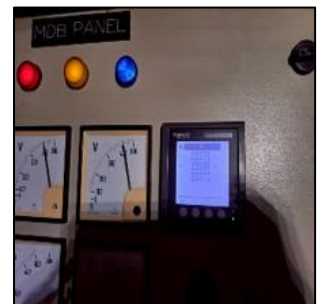
รูปที่ 3-19 การเช็คตู้คอนโทรลกระแสไฟฟ้าปั้มน้ำบาดาล
