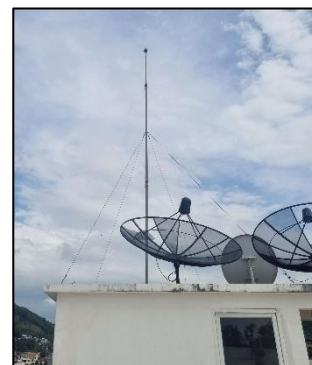
รูปที่ 3-36 ระบบป้องกันอันตรายจากฟ้าผ่า
